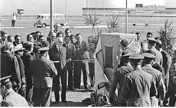
(Cerimônia de inauguração da REPLAN, em 12 de maio de 1972, com a presença do Presidente Médici e do então Presidente da Petrobrás, Ernesto Geisel.)
